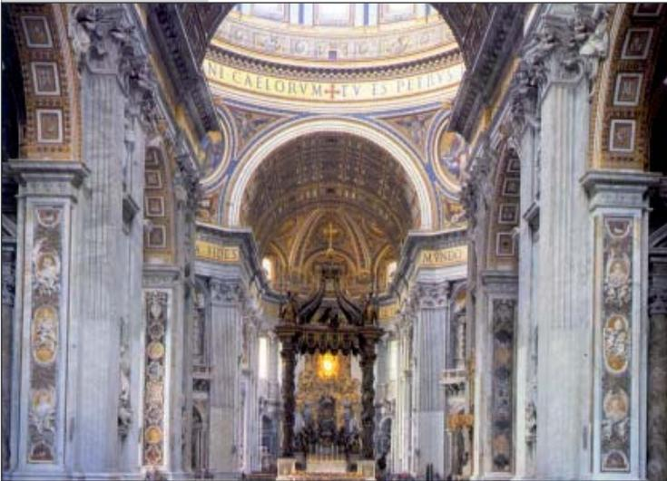
Los gigantes pilares del crucero estaban pensados para soportar el peso de la cúpula. Su fenomenal empuje necesita unos soportes como éstos. Su construcción se debe a Miguel Ángel.
