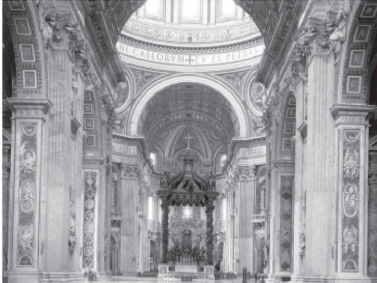
*Los gigantescos pilares del crucero estaban pensados para soportar el peso de la cúpula. Su fenomenal empuje necesita unos soportes como éstos. Su construcción se debe a Miguel Ángel.*
